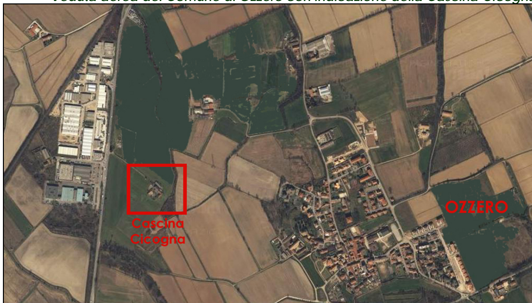
Veduta aerea del Comune di Ozzero con indicazione della Cascina Cicogna
